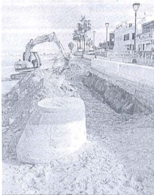
Costas inició ayer los trabajos de recuperación del paseo de Bajo de Guía.
