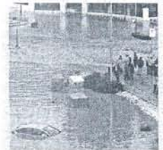
Los daños son cuantiosos.
