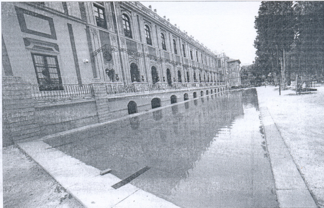
La fachada interior del Palacio de San Telmo, que será sede de la Presidencia de la Junta, reflejada en uno de los estanques. / JESÚS MORÓN
