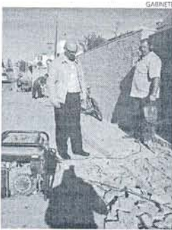
La calle necesitaba este arreglo.
