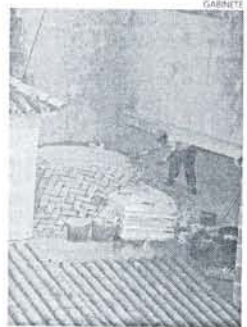
Arreglos del techo de la Iglesia.
