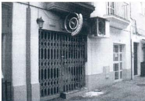
Fachada del bar El Tabanco tras el incendio.
