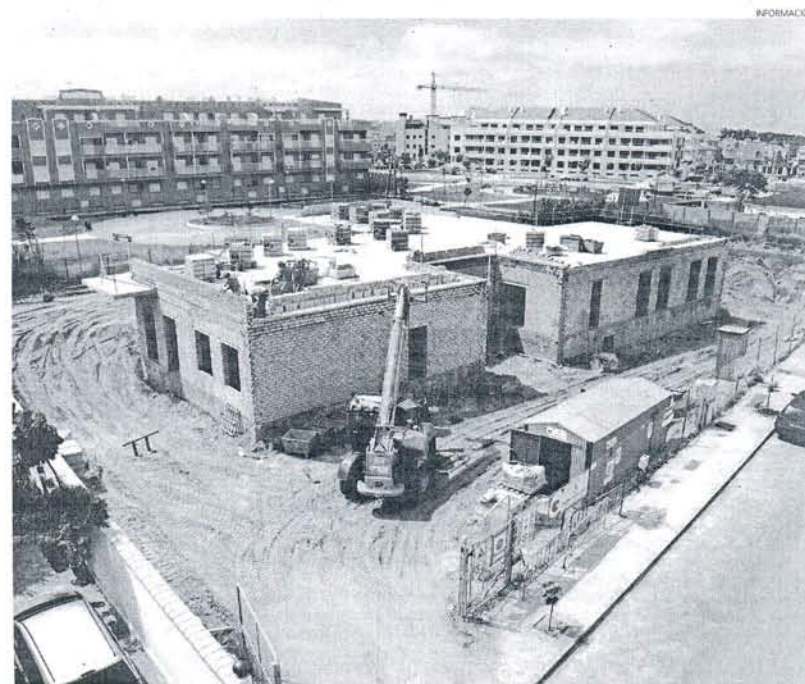
Vista de las obras, hace algunas semanas, del nuevo centro de Afanas, que se encuentra notablemente avanzado.
