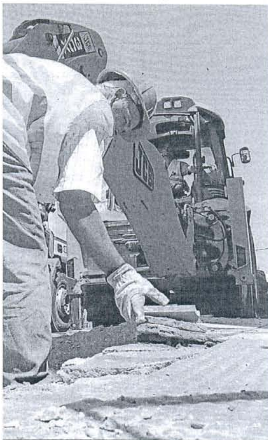
Un obrero trabaja en la vía pública en la construcción del tranvía. ELIAS PIMENTEL
