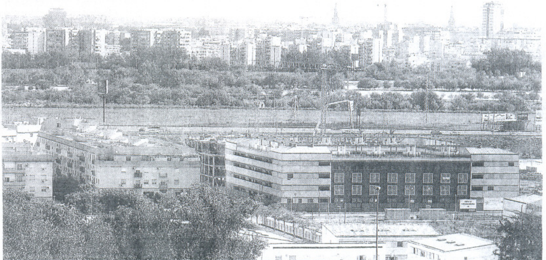
Una imagen de edificios en construcción.
