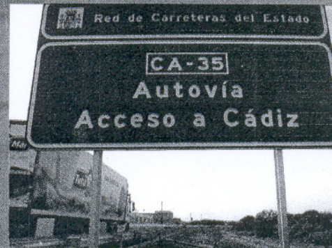
👉 Desdoble N-443. Puerto Real-Cádiz. Mañana se inaugura la nueva CA-35, que es el único proyecto concebido y ejecutado en exclusiva por el Gobierno del PSOE.
