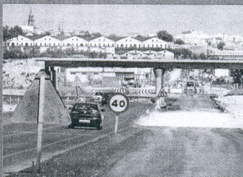
👉 Autovía Jerez-Sanlúcar-Chipiona. Chipiona y Sanlúcar ya tienen una vía decente que las une con Jerez, aunque falta aún un pequeño tramo por desdoblar.
