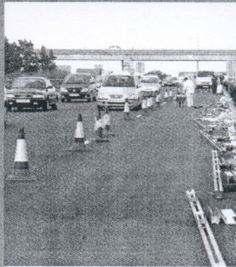
Nudo de Tres Caminos. El principal embudo de la provincia, sobre todo en verano, sigue sin proyecto.
