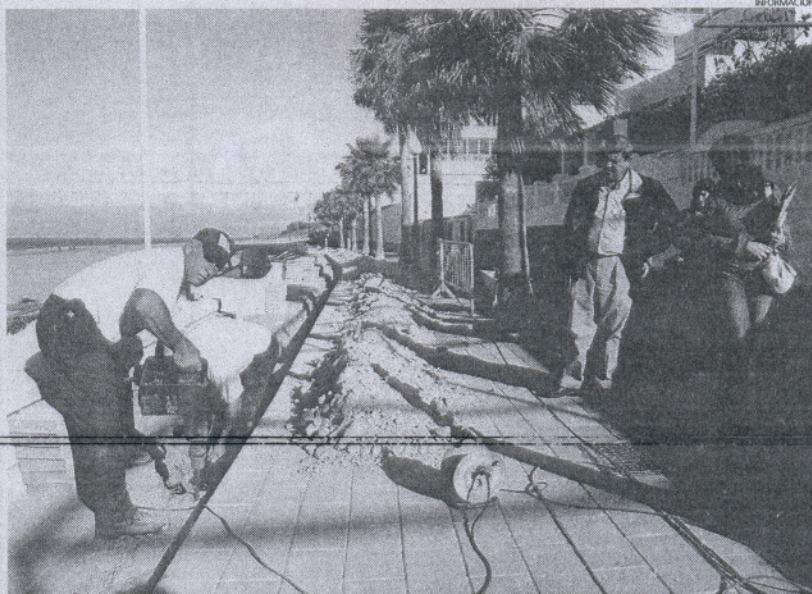
El propio delegado de Playas se acercó a comprobar como marchan las obras de instalación de la nueva red.
