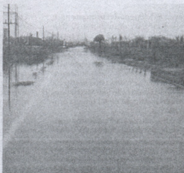
Camino de Santa Teresa, en Rota, inundado.
