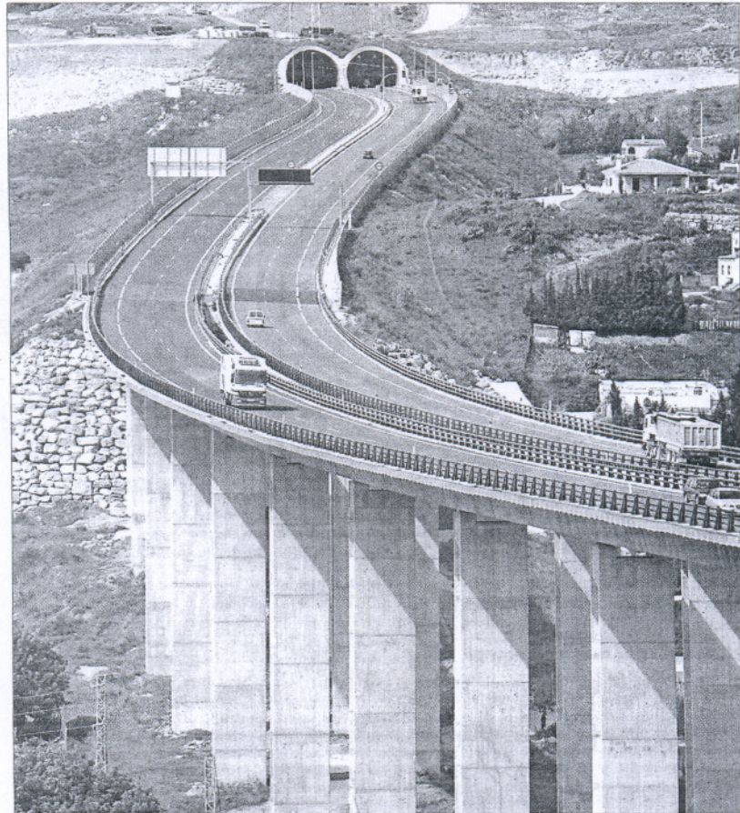
Tramo de autopista en Marbella. / JULIÁN ROJAS
