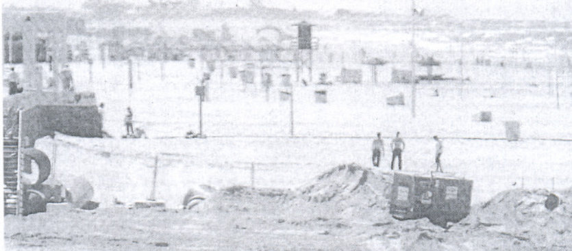
La playa de Santa Maríase encuentra en obras cuando falta un mes para que comience el verano. / E.M.
