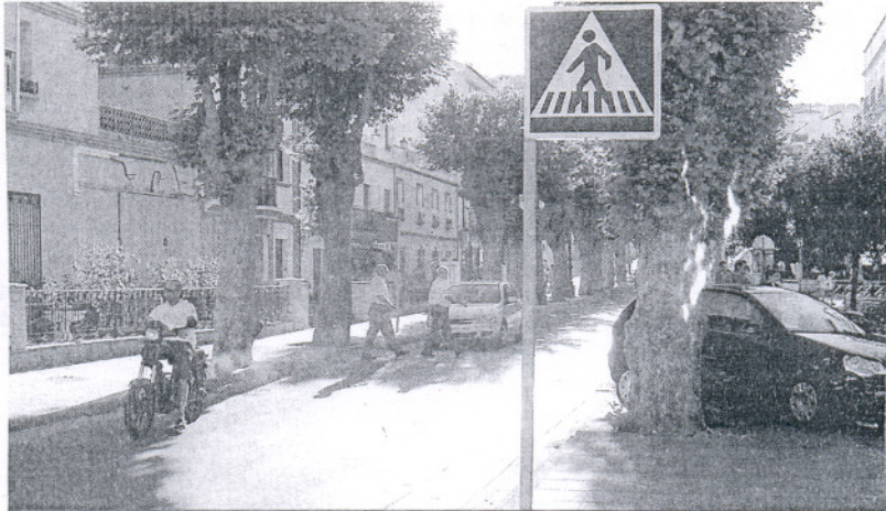
Las obras han creado pasos de peatones elevados.
