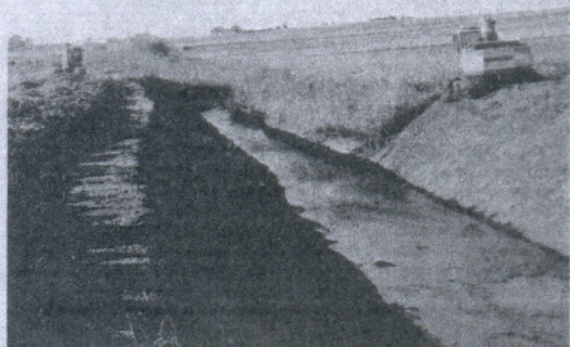
Para Ecologistas las obras están "destruyendo" la ribera del río.
