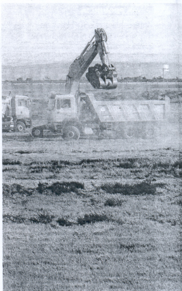
Imagen de los primeros camiones que iniciaron las obras en el polígono.
