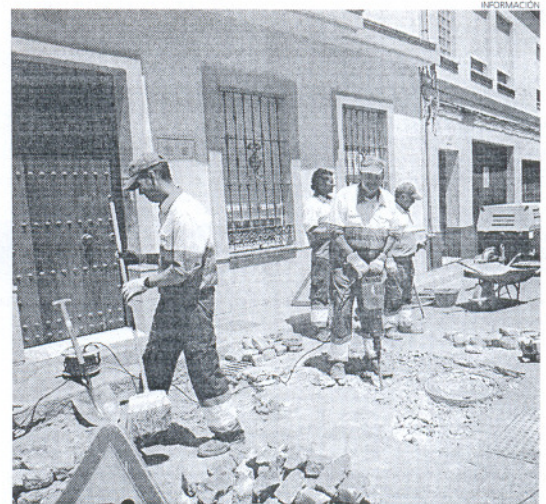
Aunque los trabajos interrumpen el tráfico, los arreglos eran urgentes.
