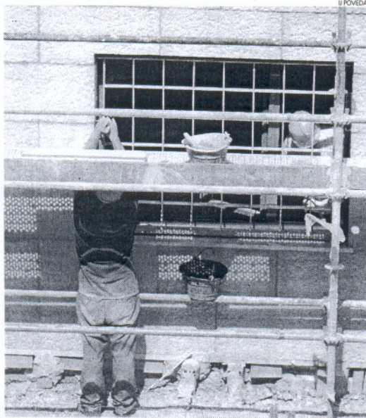
Un obrero trabaja en una de las rehabilitaciones de la Junta.
