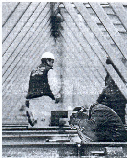
Los obreros trabajan en una infraestructura pública en Córdoba. A. CARRICONA
