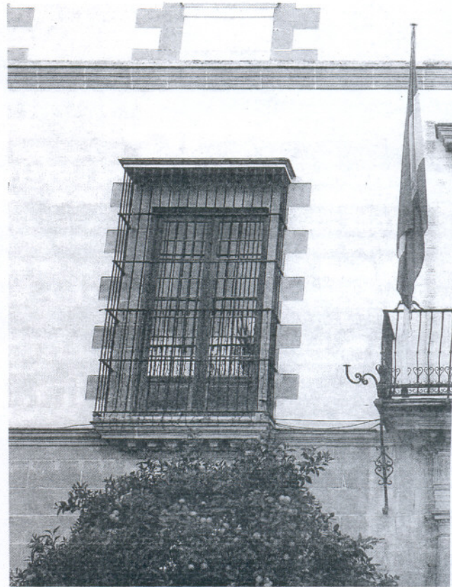
Fachada del Ayuntamiento de El Puerto de Santa María.
