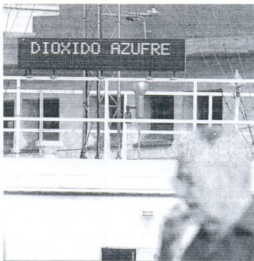
Estación de medición de la calidad del aire en Puntales.
