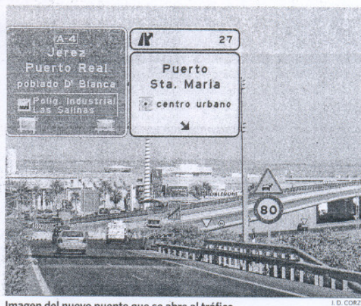
Imagen del nuevo puente que se abre al tráfico.
