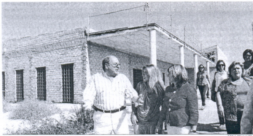
La asociación Afa Enalsa organizó ayer una visita a las obras del futuro centro, proyectado en Pino Alto.
